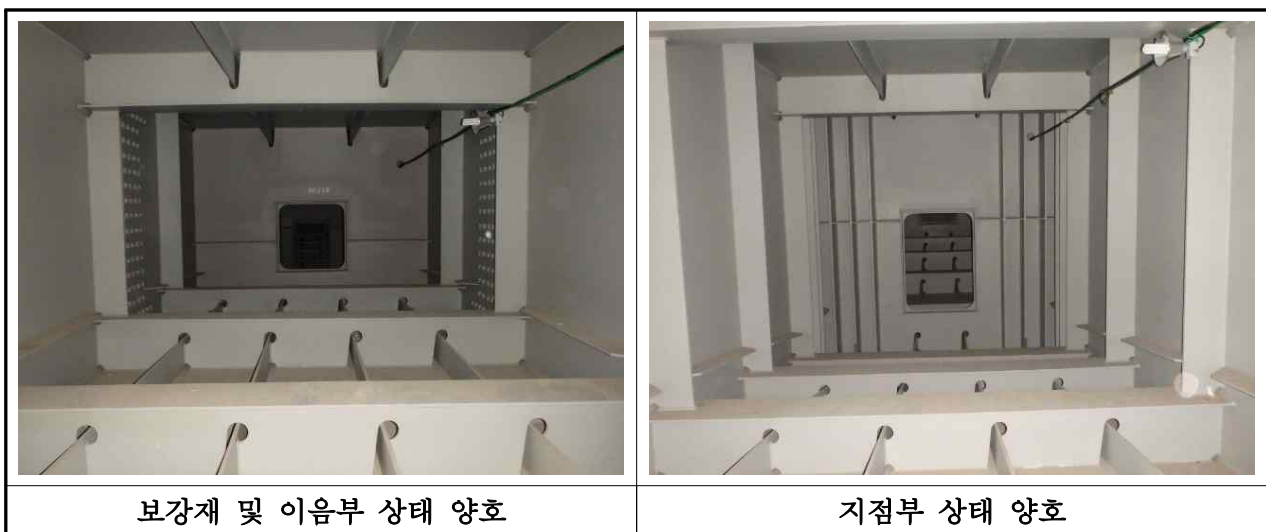
【사진 3.2.4】 강박스 거더 내부 현황(대구)
