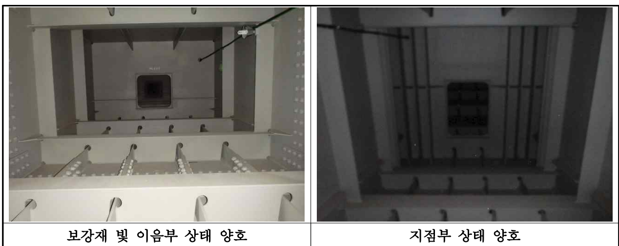
【사진 3.3.4】 강박스 거더 내부 현황(부산)
