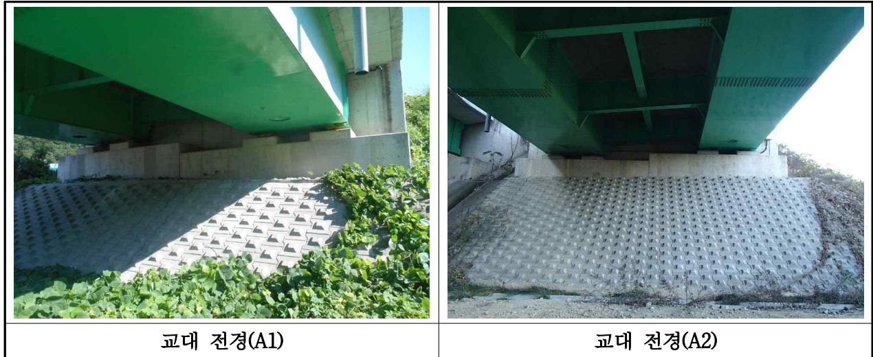
【사진 3.2.7】교대 전경(대구)
