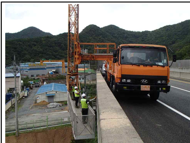
교량점검차를 이용한 조사
