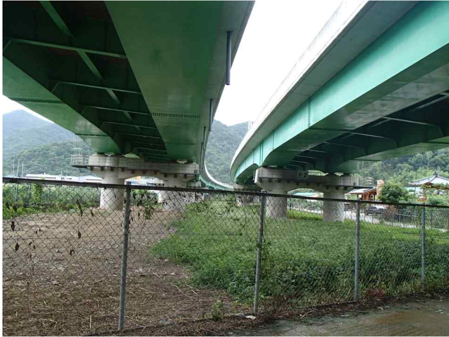
Steel Box Girder 외부 전경
