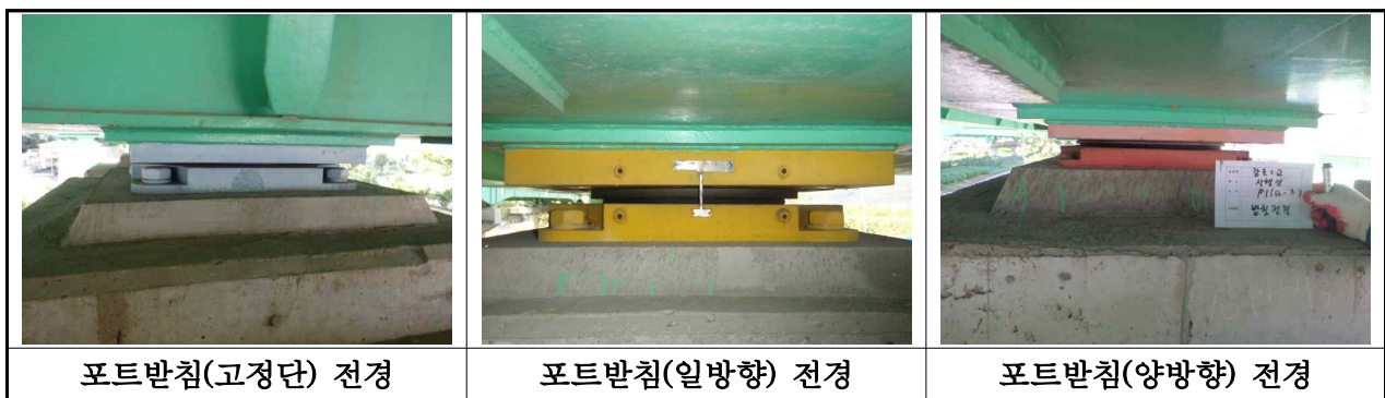
【사진 3.2.11】 교량받침 전경(대구)
