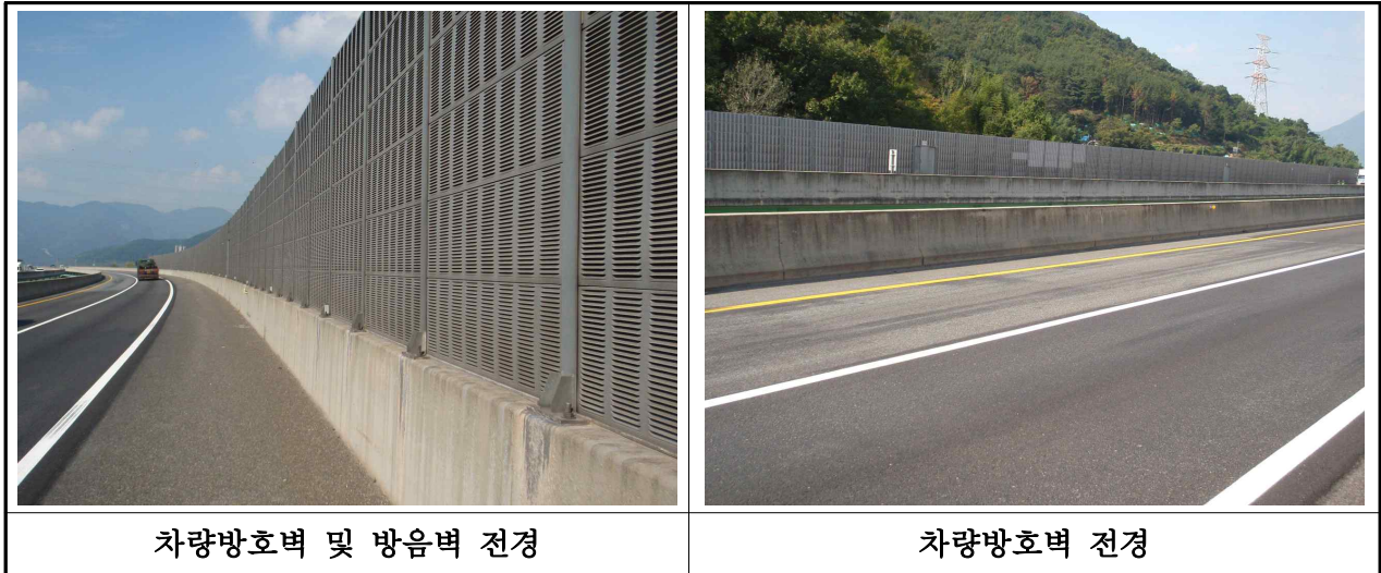
【사진 3.2.20】 방호벽 전경(대구)
