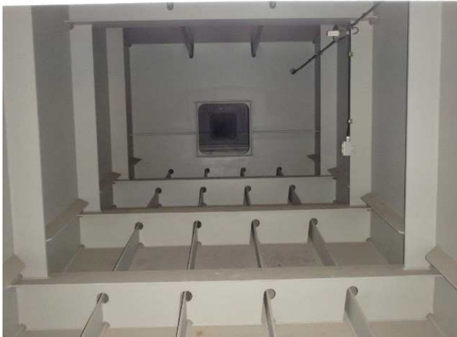
Steel Box Girder 내부 전경
