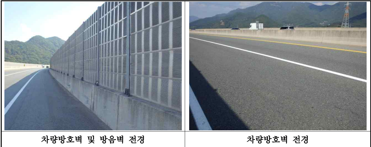
【사진 3.3.20】 방호벽 전경(부산)
