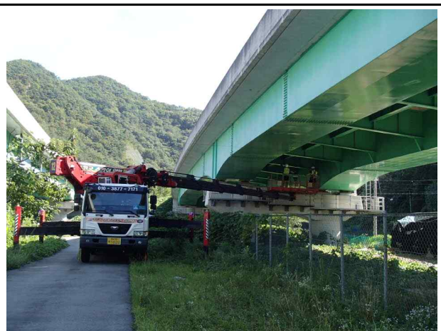
고소점검차를 이용한 조사
