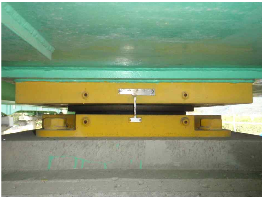
받침장치 전경 (가동단)
