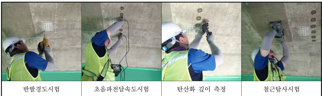
【사진 3.4.1】콘크리트 내구성조사 전경
