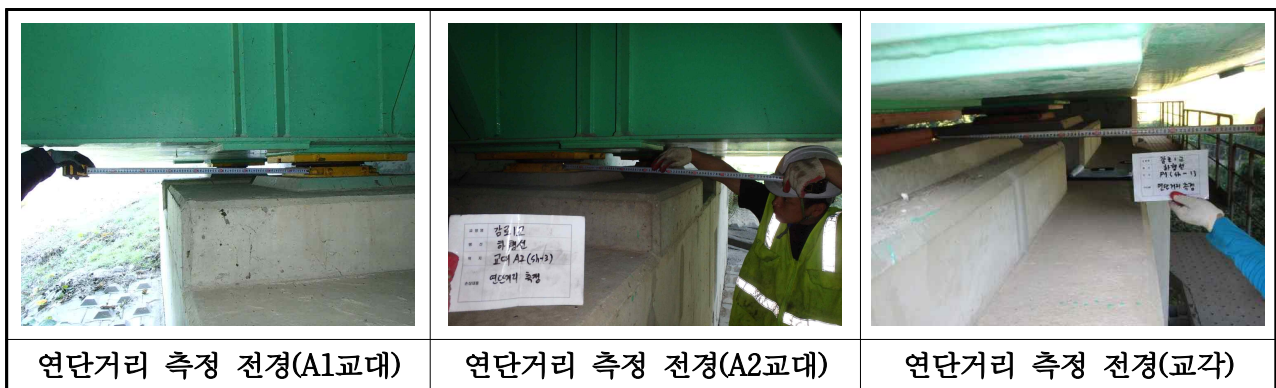
【사진 3.3.13】 연단거리 측정 전경(부산)
