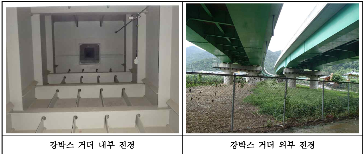
【사진 3.2.3】 강박스 거더 전경(대구)
