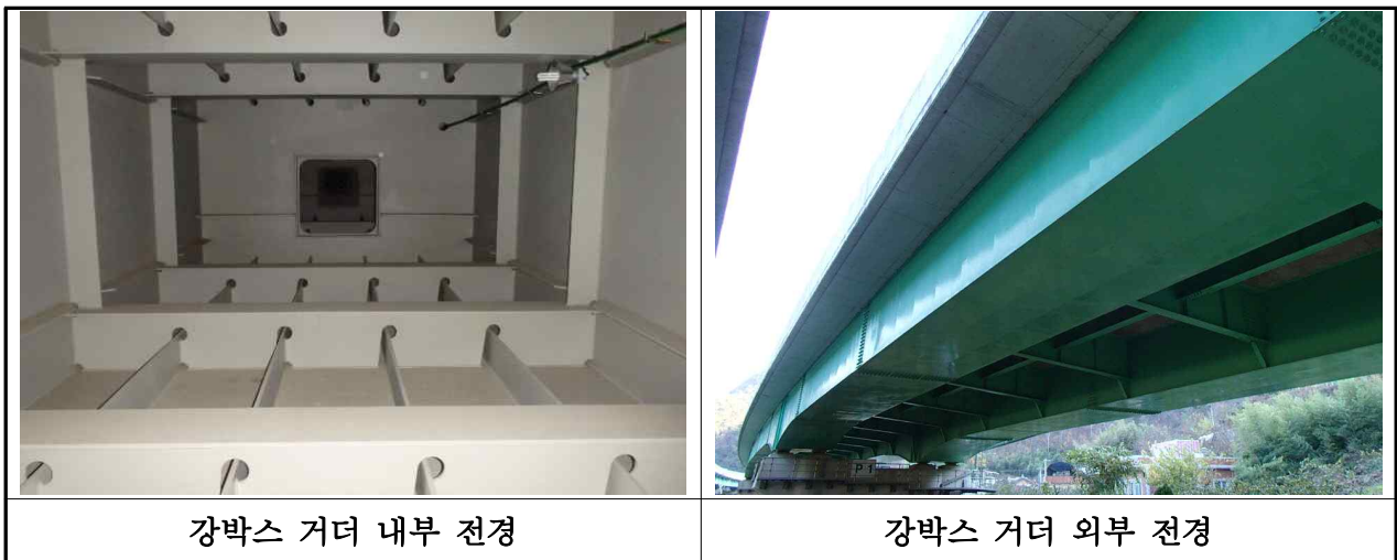
【사진 3.3.3】 강박스 거더 전경(부산)
