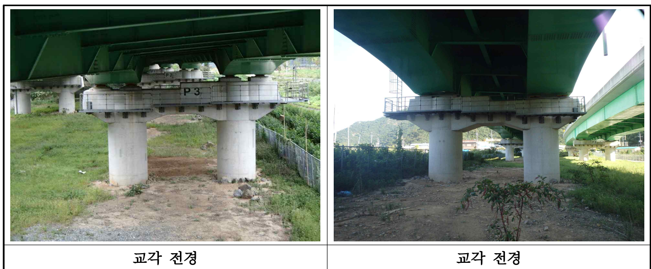
【사진 3.2.9】 교각 전경(대구)
