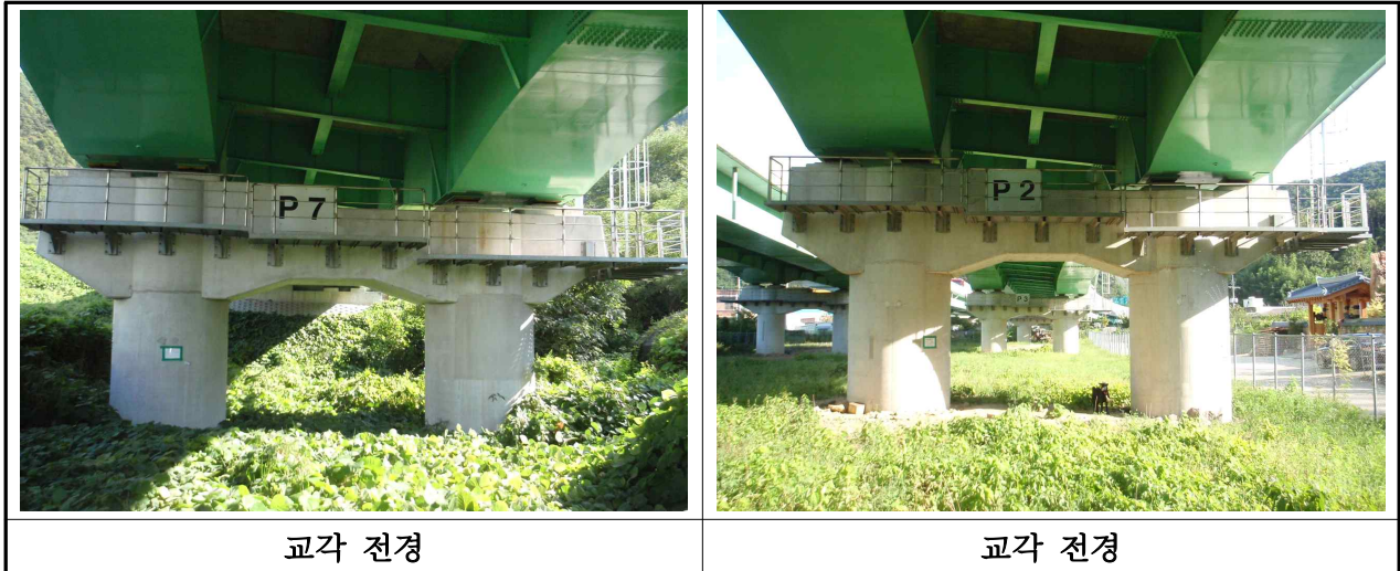
【사진 3.3.9】 교각 전경(부산)
