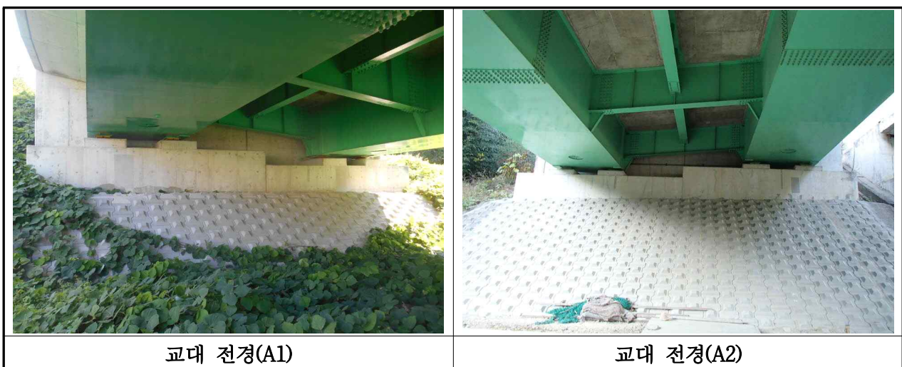
【사진 3.3.7】 교대 전경(부산)
