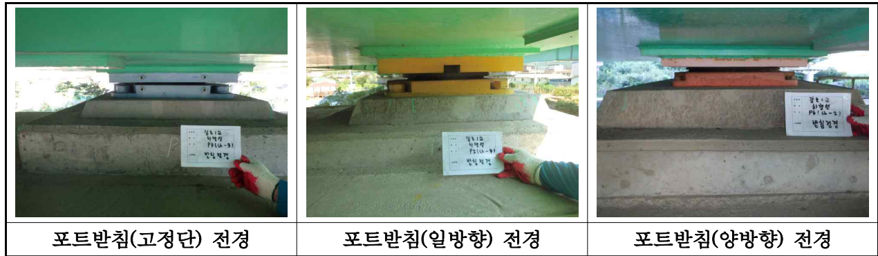
【사진 3.3.11】 교량받침 전경(부산)
