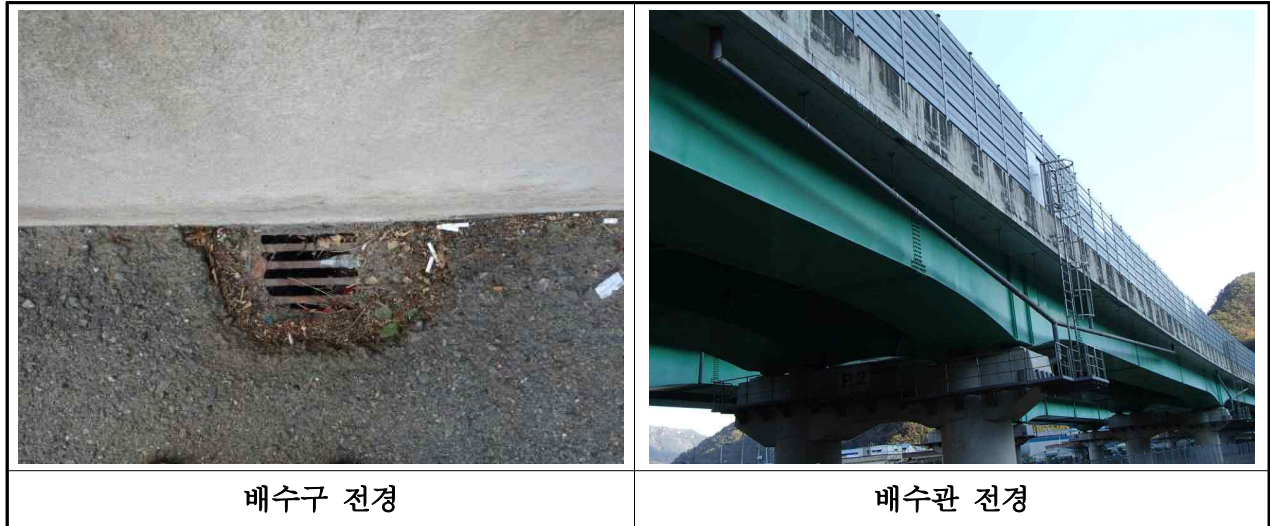
【사진 3.3.18】 배수구 및 배수관 전경(부산)
