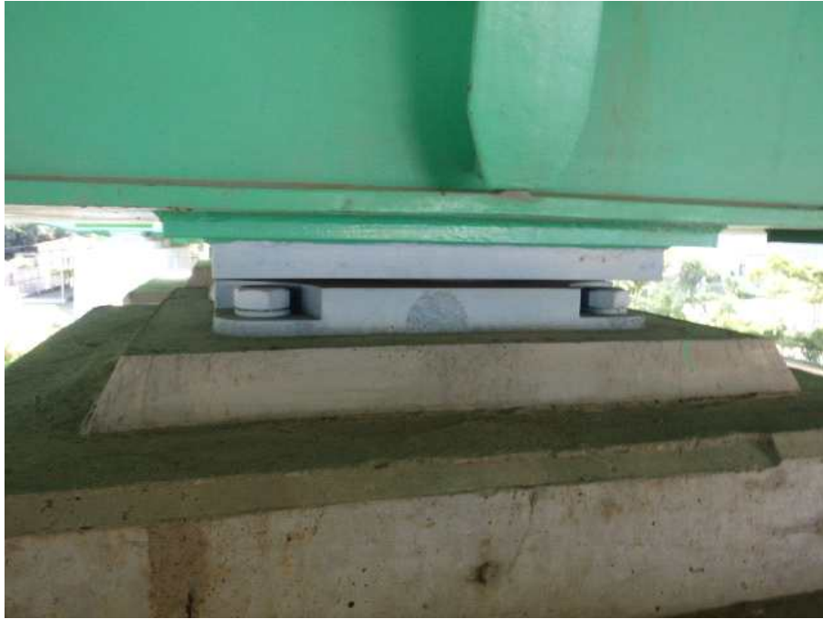
받침장치 전경 (고정단)
